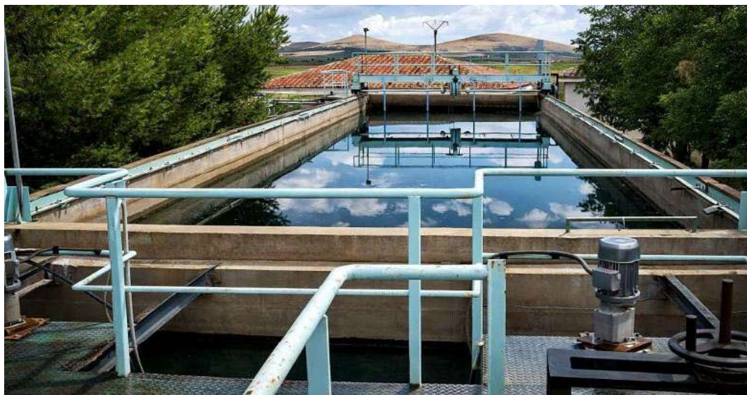
En esta semana se han instalando un total de diez caudalímetros electromagnéticos de gran diámetro distribuidos en diferentes puntos. / LT
